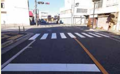
⑤中央町交差点停止線・横断歩道を更新
